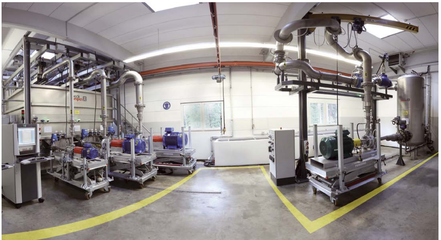
Computergesteuerte und vollautomatisierte Prüfstände im Werk von Speck in Roth.
